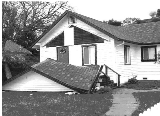
Figura 6 – Terremoto de San Simeon, Dic. 22, 2003 La entrada derrumbada no estaba debidamente conectada a la residencia.
