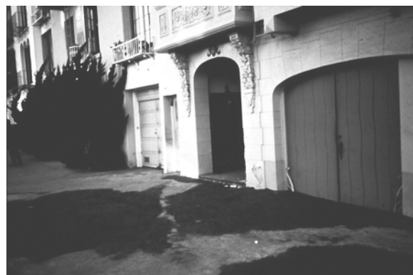
Figura 40 - Terremoto de Loma Prieta, Octubre 17, 1989. La expansión lateral, las arenas movedizas en suspensión causaron daños en el Distrito de Marina de San Francisco, a 60 millas de distancia del epicentro.
