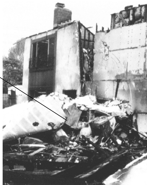
Figura 10- El calentador de agua sin refuerzo en esta casa se cayó durante un terremoto; el incendio que resultó de esto destruyó la casa.
