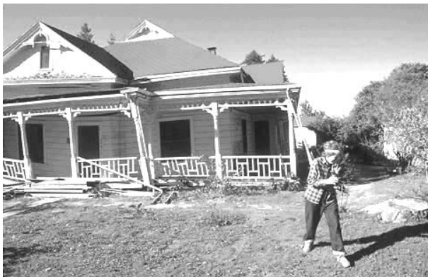
Figura 2 – Terremoto de Loma Prieta, Oct. 17, 1989 La casa se salió de sus cimientos y fue considerada una pérdida total.
