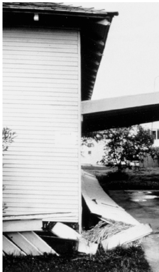
Figura 15 – Daños a la casa debido a fallas del muro bajo.
