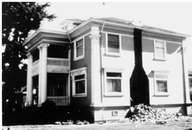
Figura 33 – Ésta es una chimenea sin refuerzo que se cayó durante un terremoto reciente.
