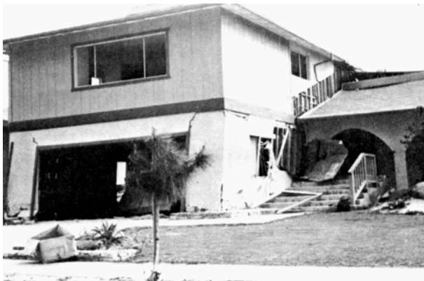
Figura 1 – Terremoto de San Fernando, Feb. 9, 1971 Daños severos entre el primero y segundo piso de la vivienda. El primer piso cayó unos 3 pies.
