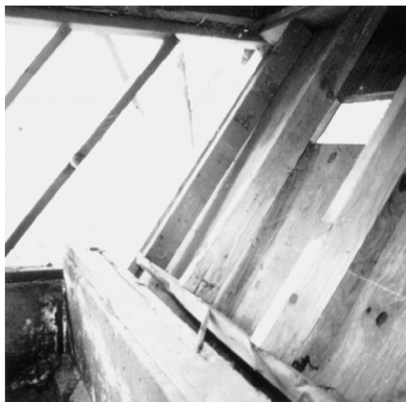
Figura 23 – Esta fotografía nos muestra el detalle interior de una casa similar a la foto de arriba, mostrando que un edificio con una pared sin refuerzo puede causar daños considerables.
