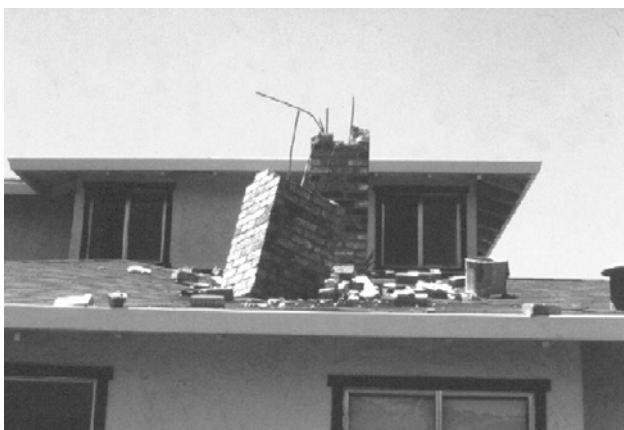
Figura 34 – Terremoto Morgan Hill. Parte de la chimenea cayó sobre el techo.
