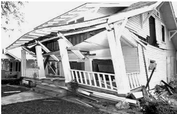
Figura 3 – Terremoto de Northridge, Ene. 17, 1994. Daño de residencia uni-familiar a causa de fallas en múltiples elementos.
